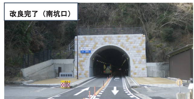
Photo. 1 改良前・改良完了
