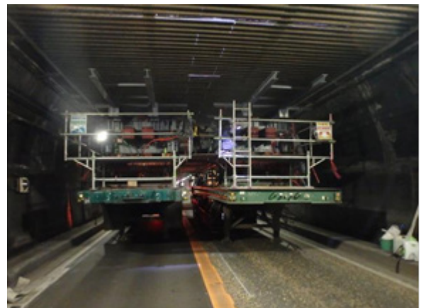
Photo. 5 リフター設置状況
