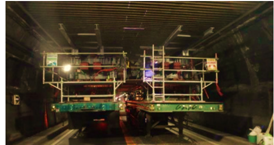
天井板撤去状況
