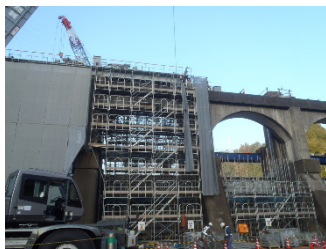
Photo. 13 支保工設置状況 Photo. 14 ワイヤーソー切断
