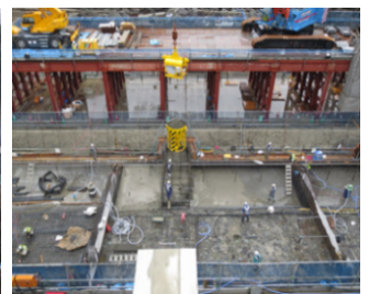
Photo. 27 着岩部打設状況
