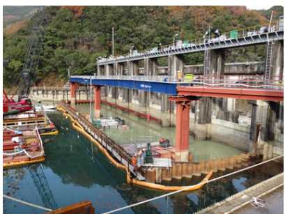
Photo. 8 止水矢板薬液注入状況（2期）
