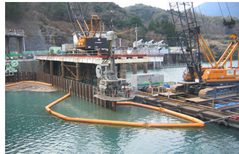
Photo. 6 仮締切鋼矢板打設状況（1 期）
