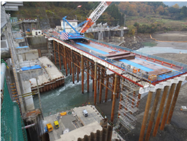
Photo. 4 上流作業構台設置状況
