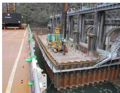
Photo. 9 エポコラム改良機
