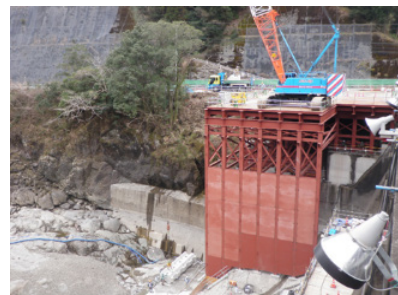
Photo. 2 右岸作業構台
