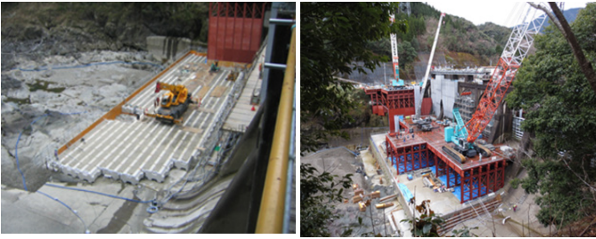
Photo. 3 河床基礎ブロック設置状況, 河床作業構台作業状況
