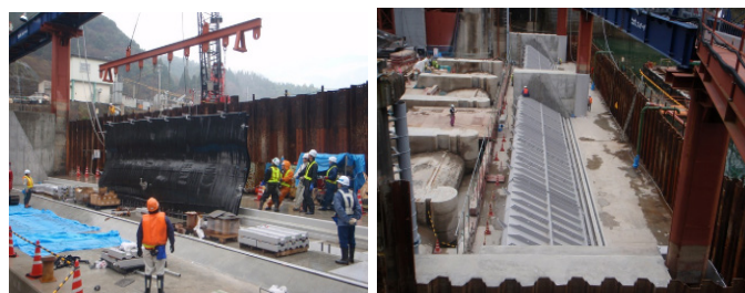
Photo. 11 ゴム袋体と扉体設置状況
