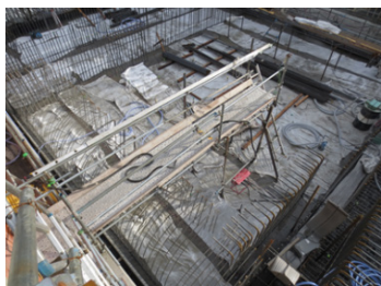
Photo. 30 マット養生状況
