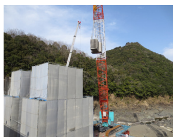
Photo. 17 切断ブロック搬出状況
