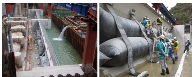
Photo. 12 試験湛水・応力計測状況
