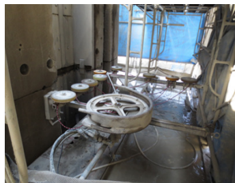
Photo. 16 ワイヤーソー切断状況
