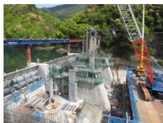
Photo. 28 ピア部施工状況
