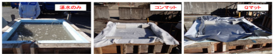
Photo. 22 細骨材仮置き状況
