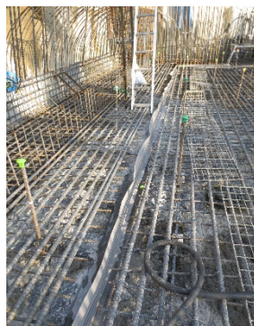
Photo. 25 止水板設置状況
