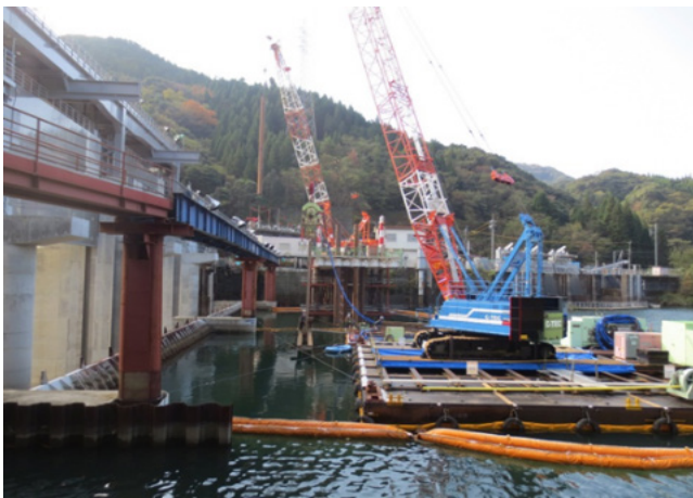
Photo. 5 80t クレーン台船作業状況（5 期工事）
