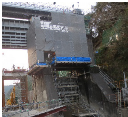
Photo. 15 支保工仮受状況
