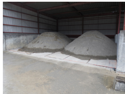
Photo. 22 細骨材仮置き状況
