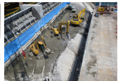
Photo. 19 堤体ブレーカ取壊し状況
