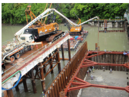
Photo. 10 右岸側均しコンクリート打設
