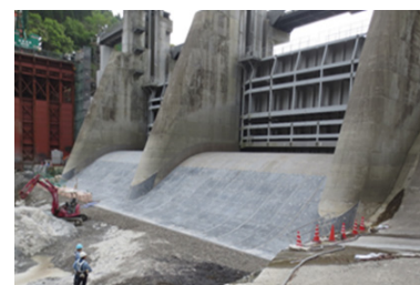
Photo. 33 越流面設置完了全景
