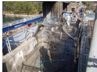
Photo. 13 支保工設置状況 Photo. 14 ワイヤーソー切断
