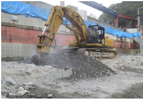
Photo. 21 ツインヘッダー切削状況
