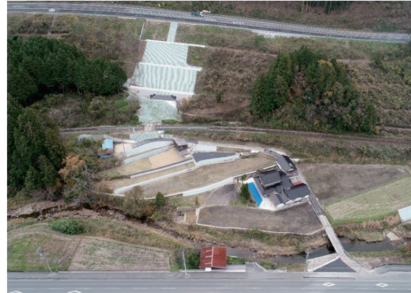
復旧対策工事完了全景
