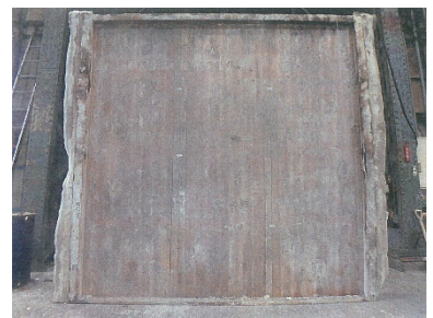
(c) 試験後の CLT 表面 (加熱側)
