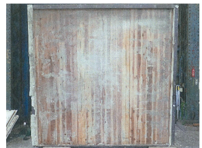
(c) 試験後の CLT 表面 (加熱側)
