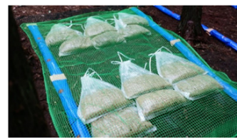
Photo. 3 吸着用PIC資材設置
