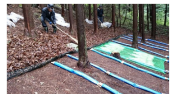
Photo. 2 汚染土壌の設置
