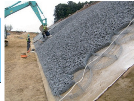
c. 砕石のり面工（メッシュリング工法）
