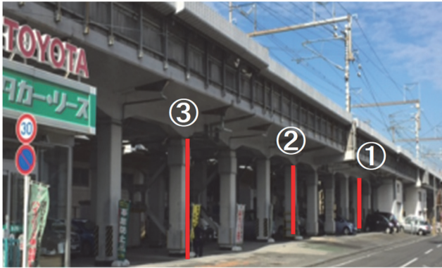
Photo. 4.1 高架橋測定位置
