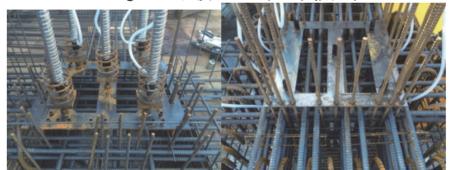
Photo. 5. 2 PC 鋼棒及び鉄筋位置アンカーフレーム
