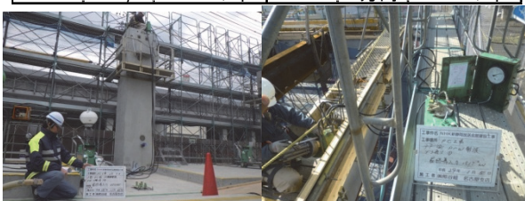
Photo 5.5 PCa 柱・梁緊張作業状況
