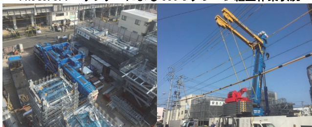
Photo. 5.8 リフターによる550tクレーン組立作業状況
