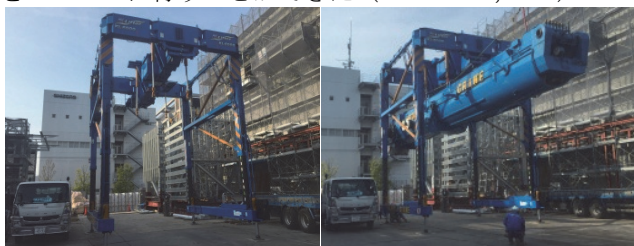
Photo. 5.7 リフターによる550tクレーン組立作業状況
