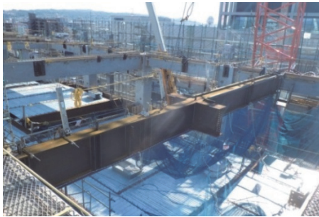
Photo 5.4 鉄骨小梁架設状況
