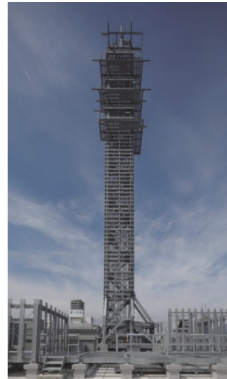
Photo. 5.12 鉄塔建方完了状況(屋上より)
