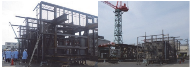
Photo 5.6 製作工場での鉄塔鉄骨仮組状況
