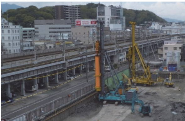
Photo. 5. 1 深層混合処理重機転倒防止対策
