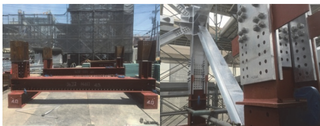
Photo. 5.9 地組ヤード及び地組状況
