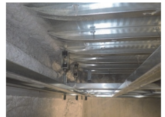
Photo. 6.4 防振遮音天井下地
