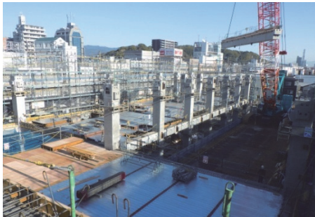
Photo 5.3 PCa 柱建方状況
