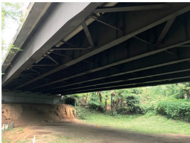
Photo. 7 実橋梁全景（南西から北側を望む）
