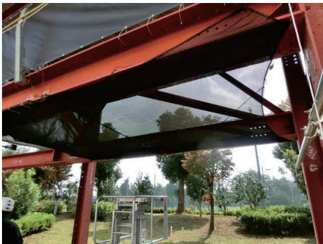
Photo. 4 はく落防止ネット取り付け状況
