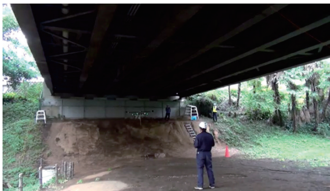
Photo. 16 ロボットの飛翔状況
