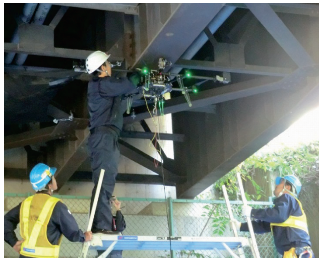
Photo. 9 ロボット設置状況
