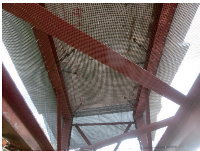
Photo. 5 はく落防止ネットを下から見た状況
