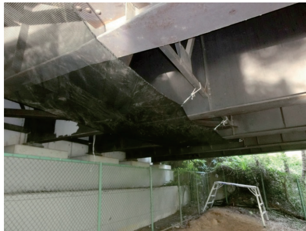
Photo. 8 はく落防止ネット取り付け状況
