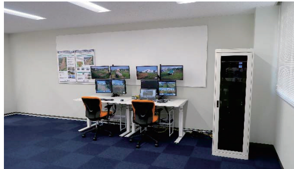
Photo. 6 常設型高機能遠隔操作室
