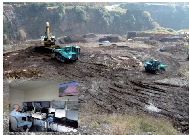
Photo.2 不整地運搬車自動走行
