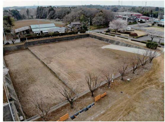
Photo.4 屋外実験ヤード整備完了 (走行ヤード②)
