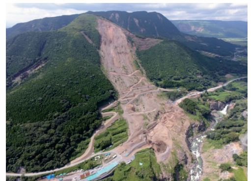
写真6 崩壊斜面(平成29年8月)
