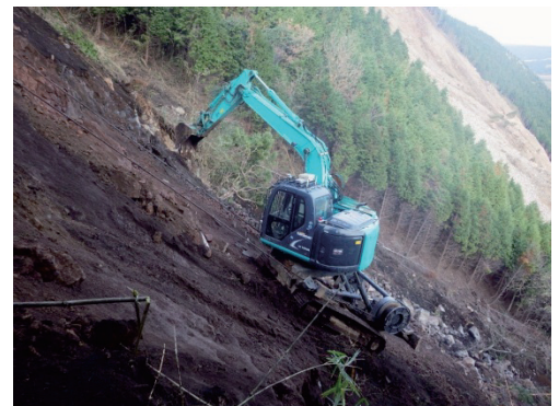
写真5 ガリー浸食部対策状況
