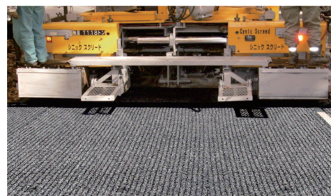
写真-1 専用フィニッシャによる数均し状況例
