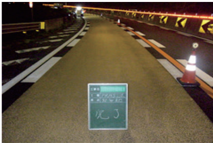
写真-3 すべり止め舗装の施工例
