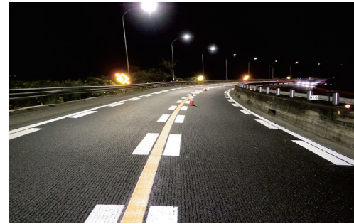
写真-4 FFP 施工直後路面状況(大道カーブ)
