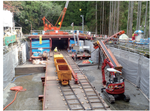
Photo. 11 トロッコ (沈砂池)
