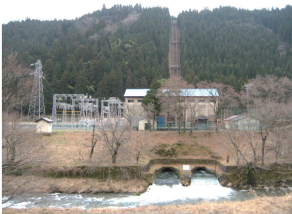
Photo. 1 広瀬水力発電所
