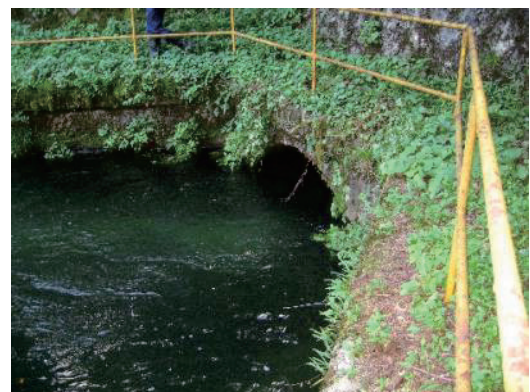
発電通水時(第3隧道出口)
