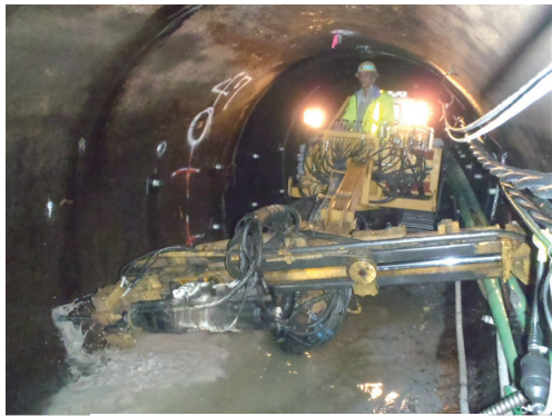
Photo. 9 ロックボルト打設
