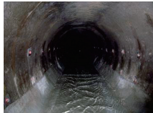
Photo. 13 インバート改修完了
