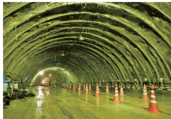
Photo. 4 減水対策施工後の状況
