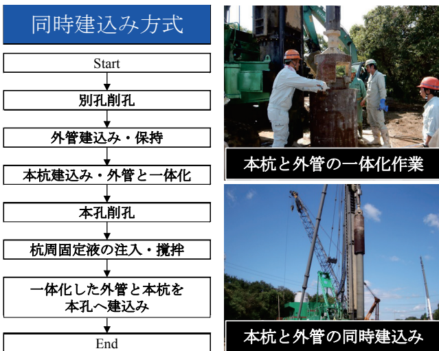
Fig. 2 同時建込み方式の施工フローおよび施工状況
