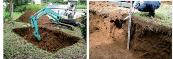
②下層部掘削状況及び検収 (GL0.5-1.0m)
