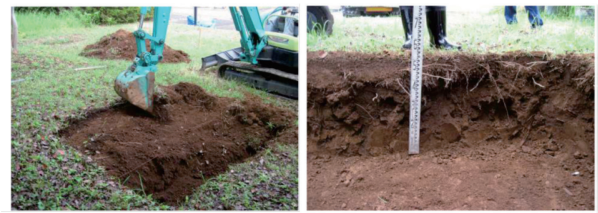
①表層部掘削及び及び検収 (GL0-0.5m)
