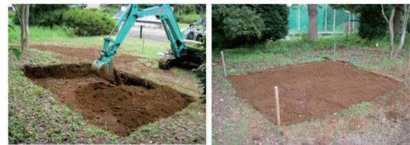
④表層部埋戻し及び表土・下層土入れ替え完了
