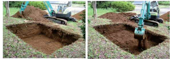
③掘削完了及び下層部埋戻し
