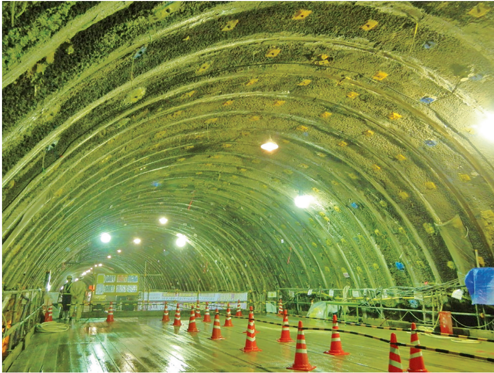
減水対策施工後
