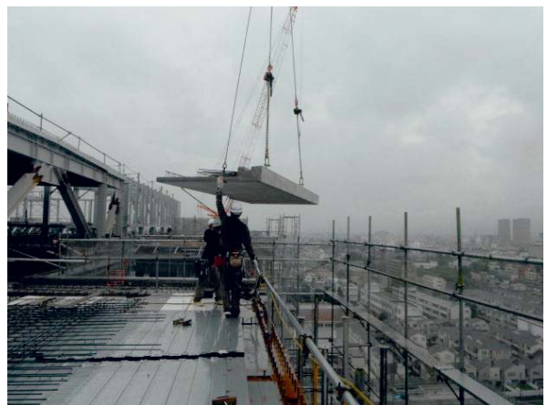
Photo. 8 バルコニー PC a 設置
