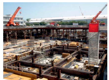
Photo. 5 地下鉄骨建方状況
