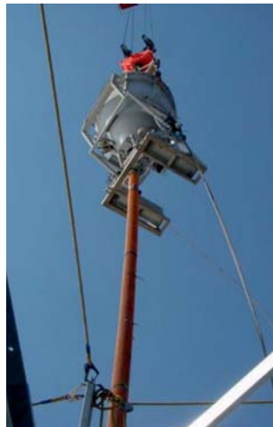
Photo. 19 フレキシブルホースを取り付けたホッパー
