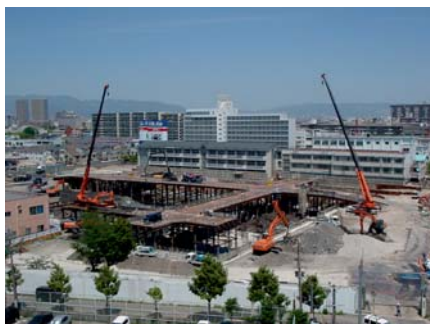
Photo. 3 地下構台架設状況
