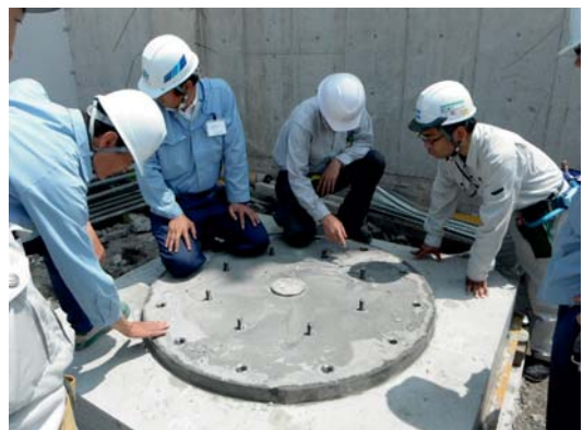
Photo. 16 グラウト試験施工で充填状況の確認
