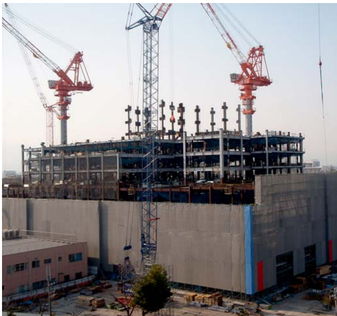
Photo. 6 地上部鉄骨建方
