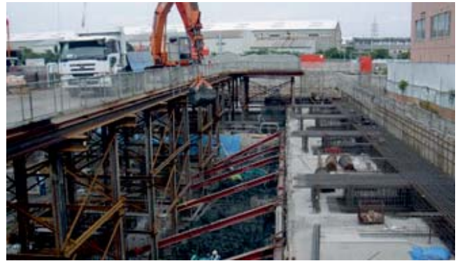
Photo. 17 斜梁設置状況
