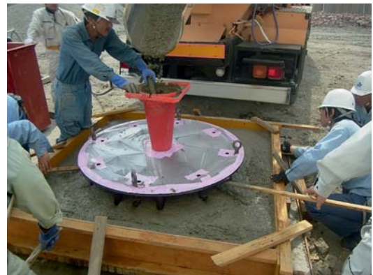
Photo. 15 下部基礎コンクリート試験施工
