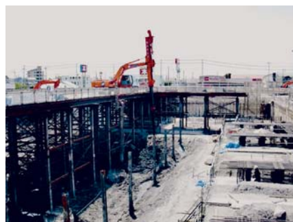
Photo. 4 地下掘削状況
