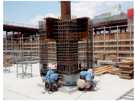
Photo. 11 免震装置設置（基礎免震）
