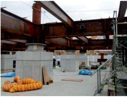
Photo. 9 免震装置設置（柱頭免震）
