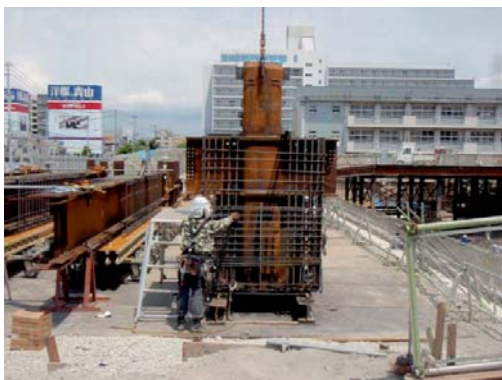
Fig. 12 鉄骨鉄筋先組工法
