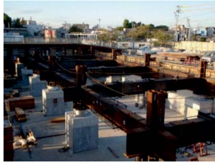
Photo. 10 免震装置設置（柱頭免震）
