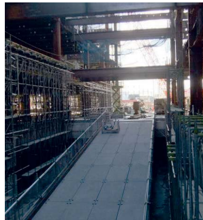
Photo. 7 地下へ降りる仮設スロープ
