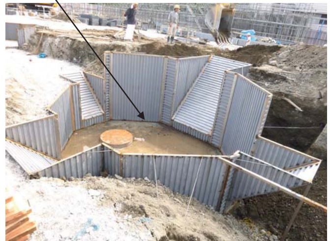
Photo.8 基礎下部鋼製型枠
