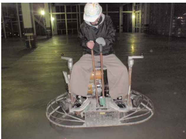
Photo. 17 騎乗式鏡面仕上げ施工
