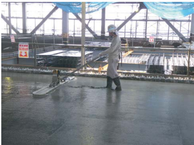
Photo. 16 サーファー施工
