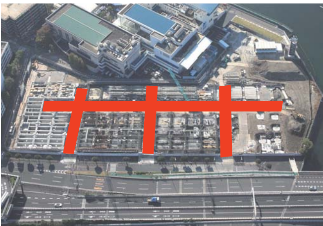
Photo. 4 中抜き工法 (中抜きエリア表記)
