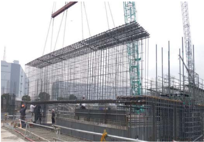
Photo. 9 地中梁セット状況
