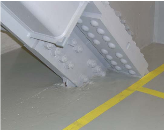
Photo. 11 ブレース下部埋込み状況
