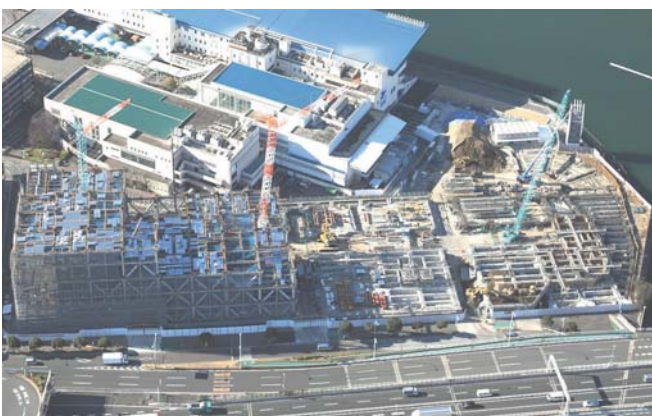
Photo. 5 中抜き工法 (鉄骨建方・基礎躯体工事)
