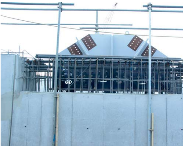
Photo. 12 地中梁ガセットプレート取付け状況
