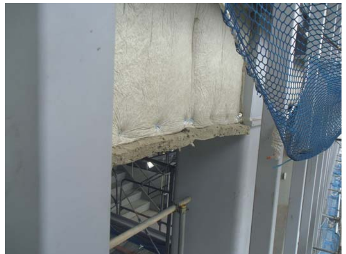
Photo. 13 耐火被覆先行取付け状況
