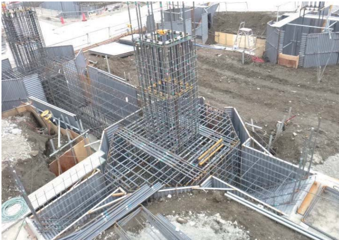
Photo. 10 基礎下部配筋状況
