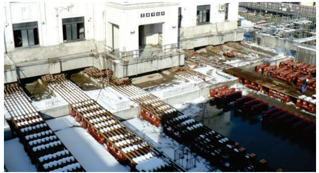
Photo. 13 転動路盤設置状況①
