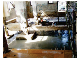
Photo. 6 建物内部の礎盤の構築
