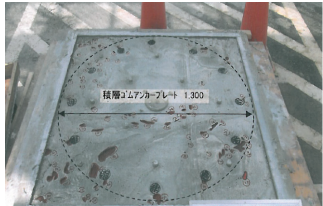
Photo. 21 無収縮モルタル施工試験の状況
