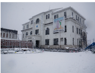
Photo. 19 曳家を完了した旧本庁舎
