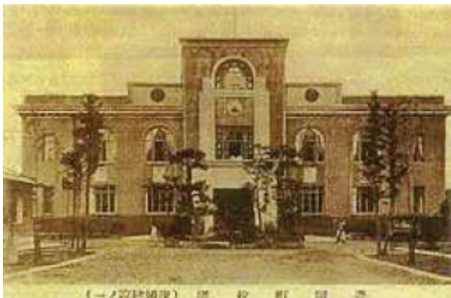
Photo.1 建築当時の豊岡町役場 （豊岡市ホームページより）
