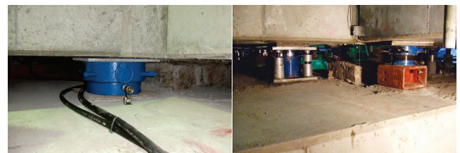
Photo. 11 ジャッキアップ状況① (左) 1 日目 (2011 年 12 月 13 日) 10mm アップ (右) 9 日目 (2011 年 12 月 21 日) 170mm アップ
