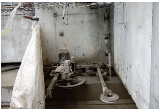
Photo. 7 ワイヤーソー (柱切断機)
