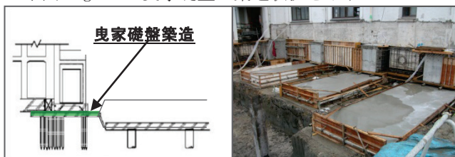
Fig. 13 移設先側の曳家礎盤築造の状況
