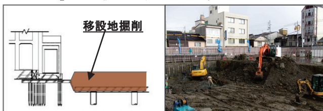
Fig. 14 移設先の掘削状況
