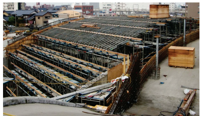
Photo. 7 ビーム架設状況
