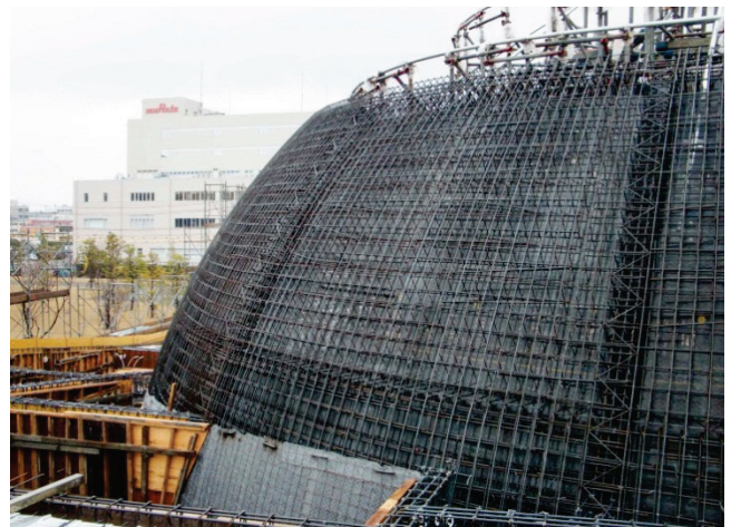
Photo. 11 下部トラスウォール建込
