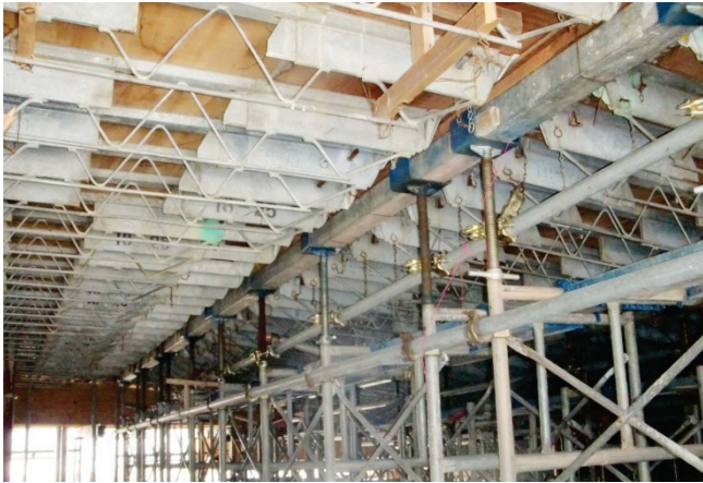
Photo. 8 ビーム架設状況
