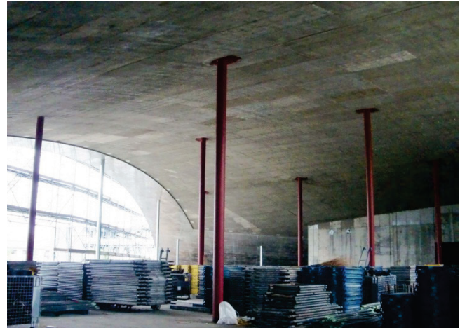
Photo. 9 支保工解体状況
