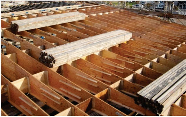
Photo. 2 くし型枠配置・調整状況
