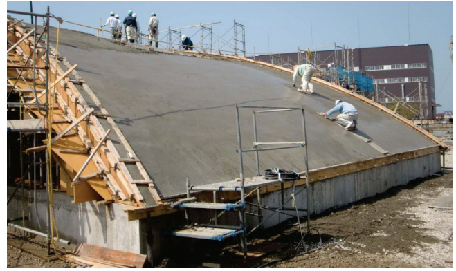
Photo. 6 上筋配筋後コンクリート打設
