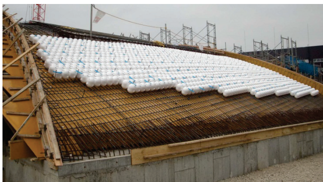
Photo. 5 ポールボイド据付状況
