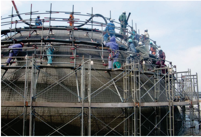
Photo. 13 球形ドーム(上部)コンクリート打設状況
