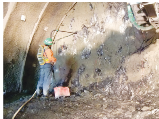
Photo. 3 遠隔装填による爆薬装填
