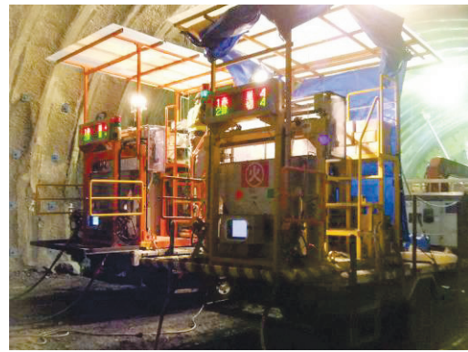
Photo. 1 爆薬の遠隔装填装置
