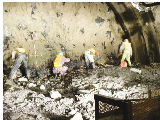
Photo. 2 人力による装填作業
