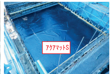
Photo. 9 底版上面養生
