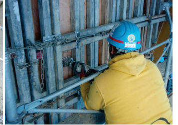
Photo. 19 壁打ちパイプレータ
