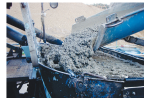
Photo. 1 SEC練りコンクリート
