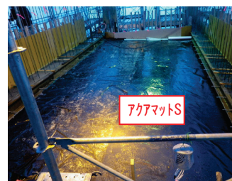
Photo. 10 頂版上面養生
