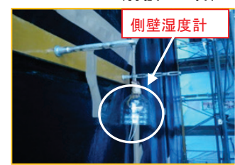
Photo. 37 側壁湿度測定
