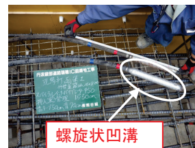
Photo. 2 スパイラルインナーバイブレータ Fig. 5 回転方向の効果
