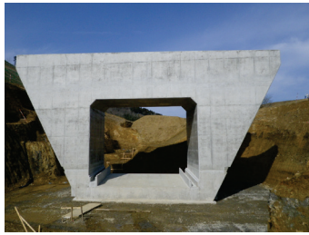
Photo. 44 函渠正面（起点側）
