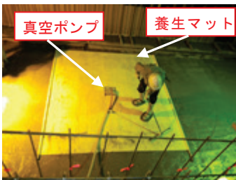
Photo. 14 真空脱水処理状況
