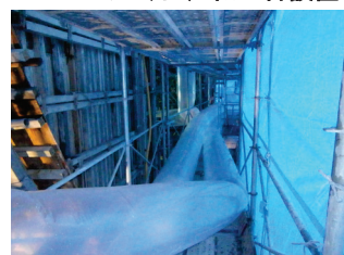
Photo. 31 シート内風管養生(2)
