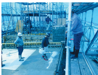
Photo. 16 養生剤散布状況
