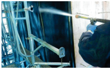
Photo. 40 養生マット散水状況
