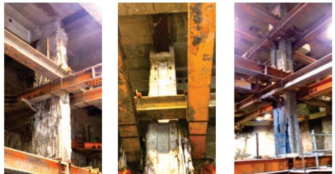
Photo. 8 RCキングポスト部分水平切梁施工状況
