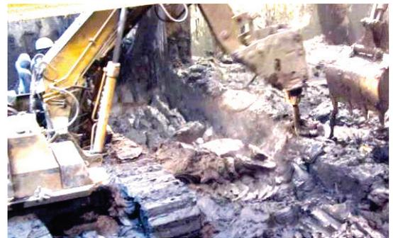
Photo. 3 隔壁天端はつり施工状況
