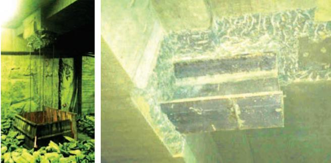
Photo. 10 RCキングポスト撤去作業（撤去状況）
