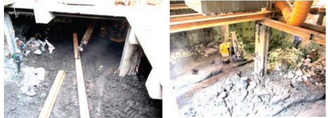
(左) Photo. 6 B1F水平切梁施工状況
