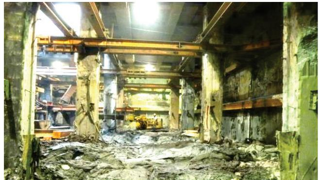
Photo. 9 RCキングポスト部分掘削施工状況
