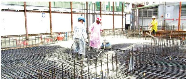
1階スラブ・梁 コンクリート打設状況
