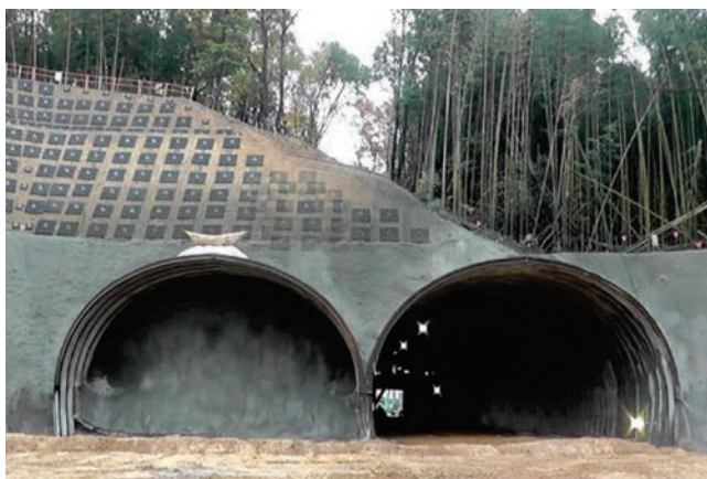
Photo. 4 起点側坑口全景
