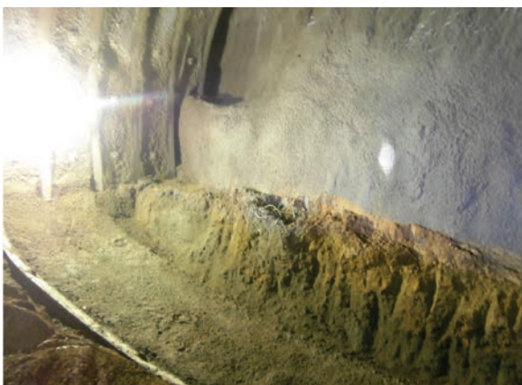
Photo. 1 インバート吹付け実施状況
