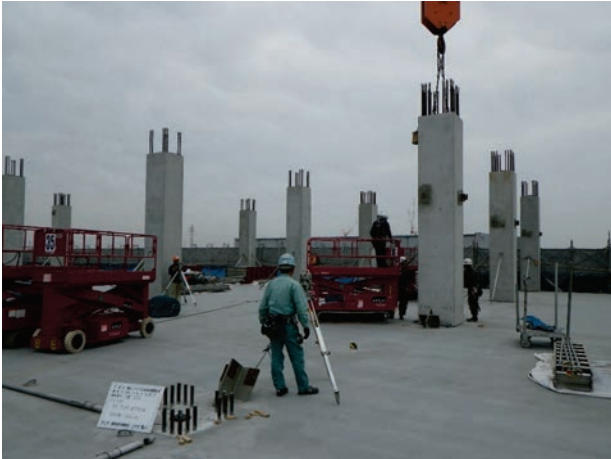
Photo. 6 柱P C aの取付状況
