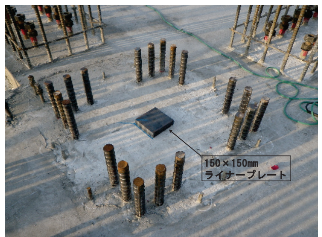
Photo. 5 ライナープレートセット状況
