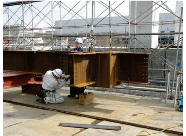
Photo. 8 大梁の地組状況
