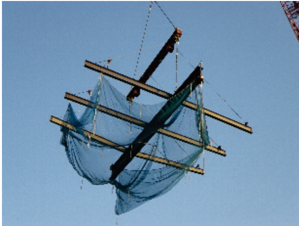
Photo. 11 小梁の地組状況
