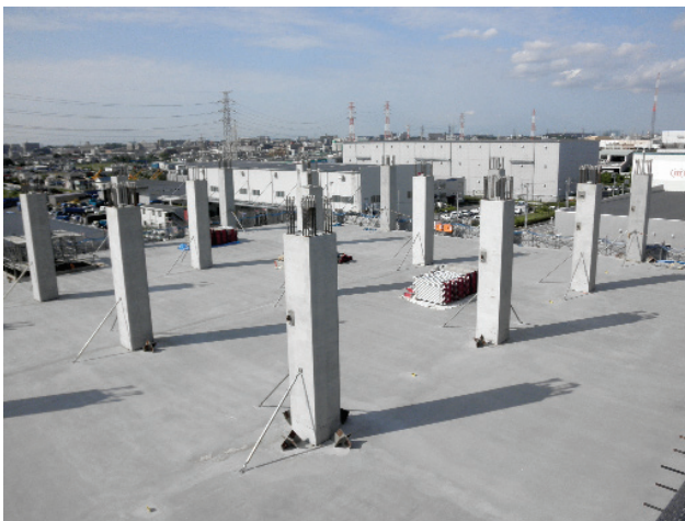
Photo. 7 柱P C a 取付完了状況
