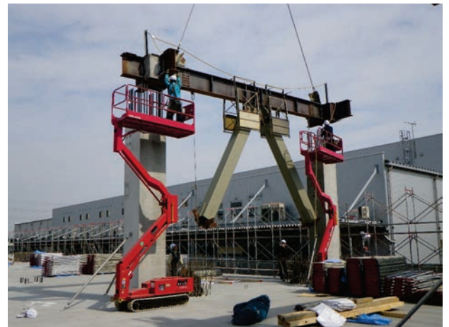
Photo. 9 大梁の取付状況
