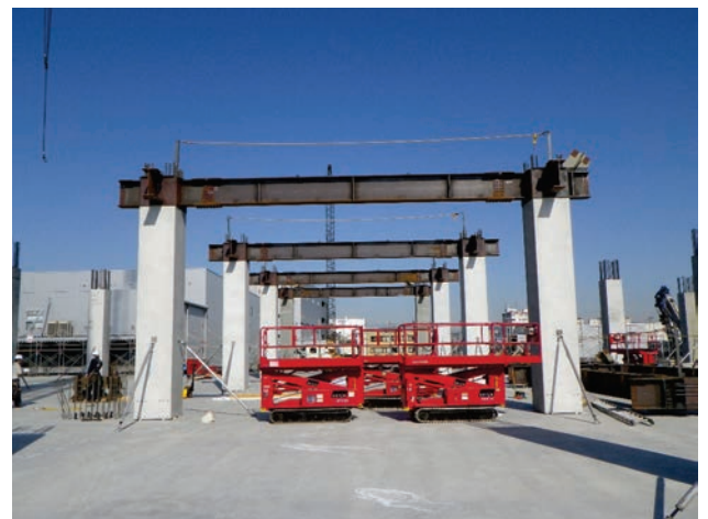
Photo. 10 大梁の取付状況
