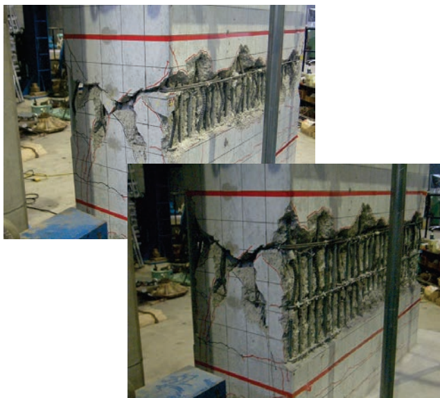
①No. 1 供試体の損傷状況とはつり後の状況
