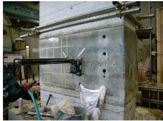
③躯体削孔状況
