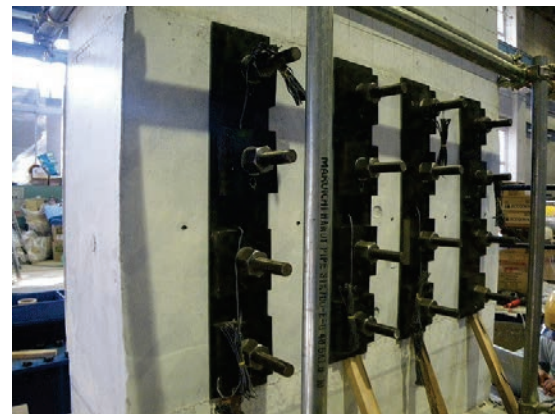
④帯板鋼板設置状況
