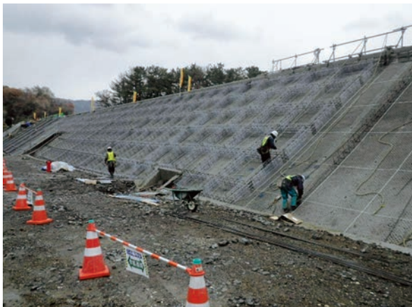
法面施工状況
