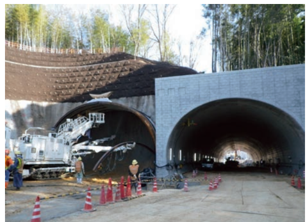
二次覆工先行施工
