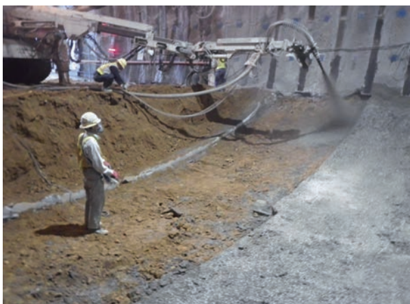
吹付インバート施工状況
