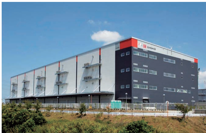
竣工写真 (外部)
