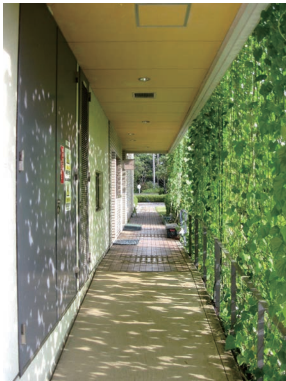
緑のカーテンで遮光された屋外通路
