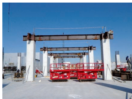
大梁の取付状況
