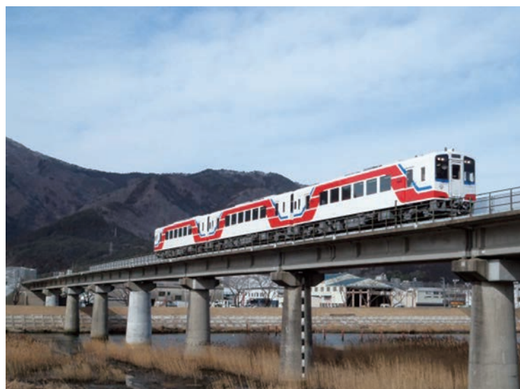
盛地区完成写真 (盛川橋りょう)
