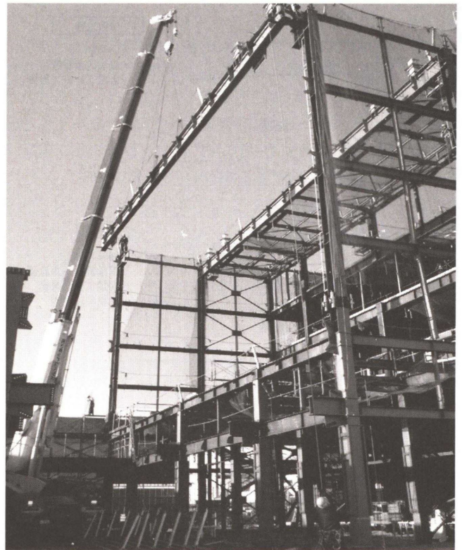
Photo. 4 鉄骨建方 大梁取付
