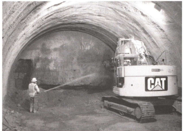
Photo 2 改良体内部掘削状況
