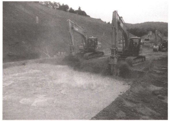
Photo 1 セメント安定処理状況
