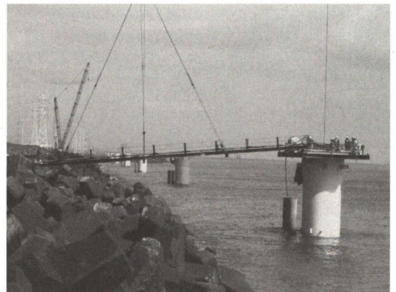
Photo. 9 中詰めコンクリート打設状況
