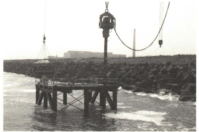
Photo. 1 障害物探針状況
