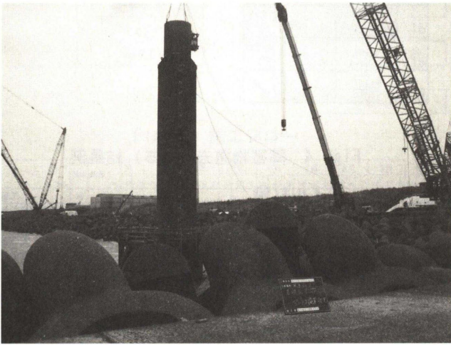
Photo. 6 ヤットコ設置状況
