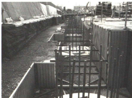
Photo. 3 鋼製捨て型枠+HRパイル 施工状況
