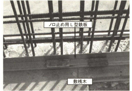
Photo. 11 ノロ止め用 L 型鉄板
