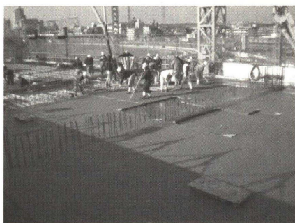
【第8日】梁・スラブ-Hコンクリート打設
