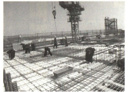
【第6-7日】スラブ配筋
