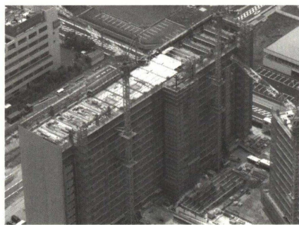
【躯体サイクル施工状況】
