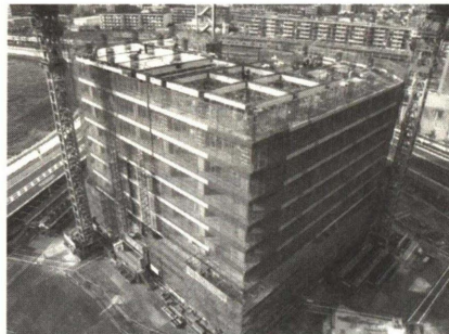
〔躯体サイクル施工状況〕
