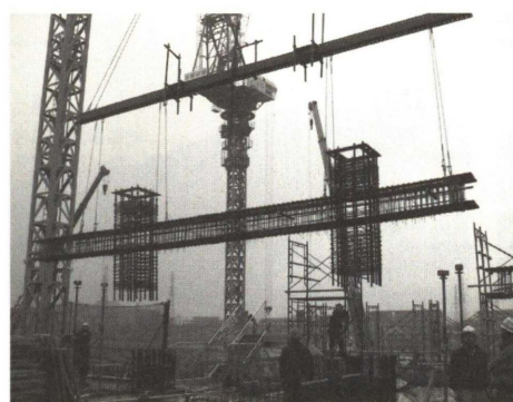
Photo. 6 サの字型柱梁鉄筋先組みユニット
