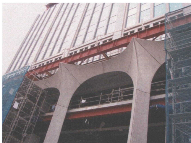
低層部GRC取付状況
