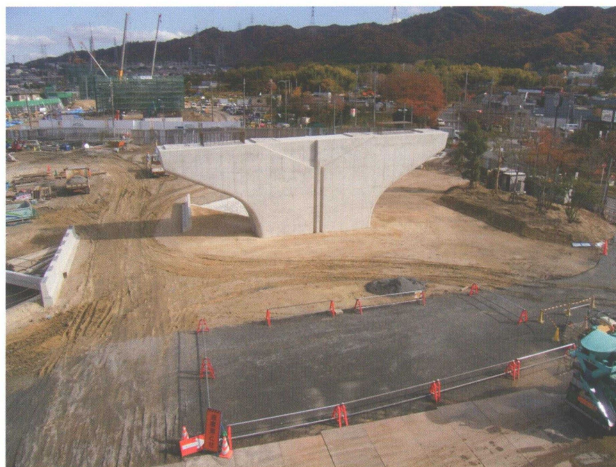
橋脚完成時点
