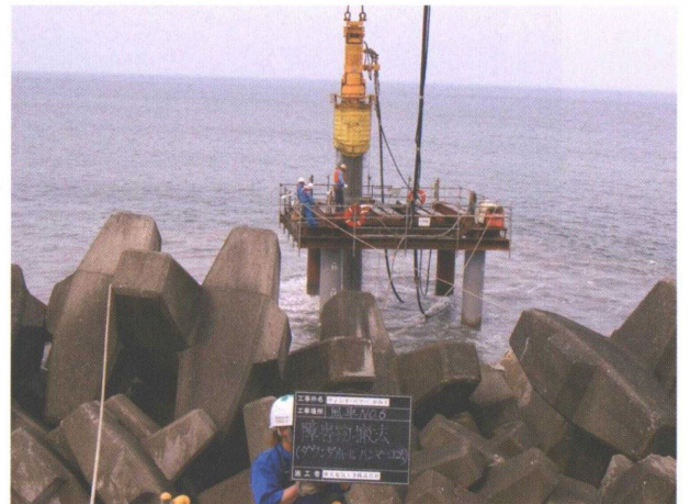
ダウンザホールハンマー施工状況
