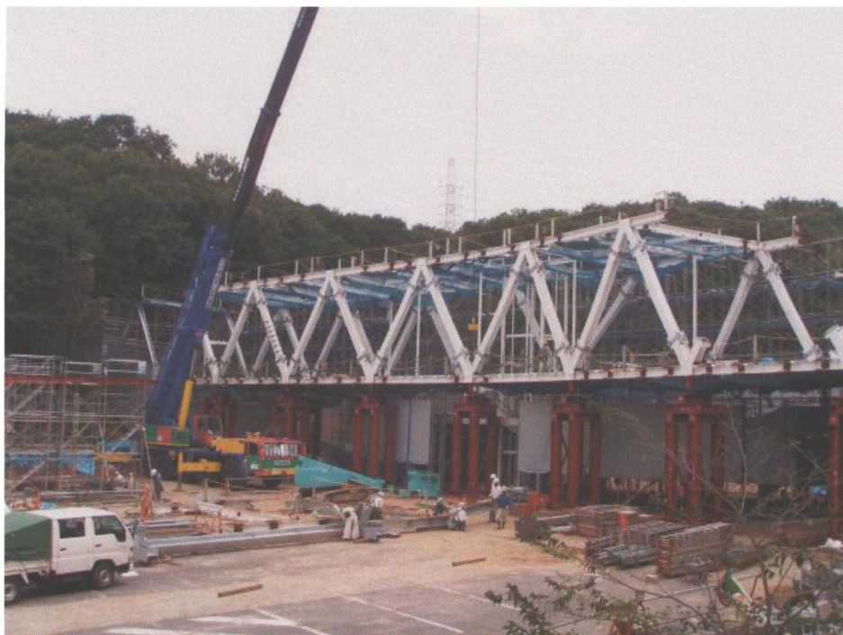
鉄骨建方の状況
