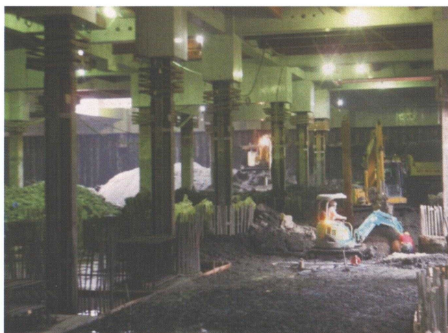
逆打ち施工状況
