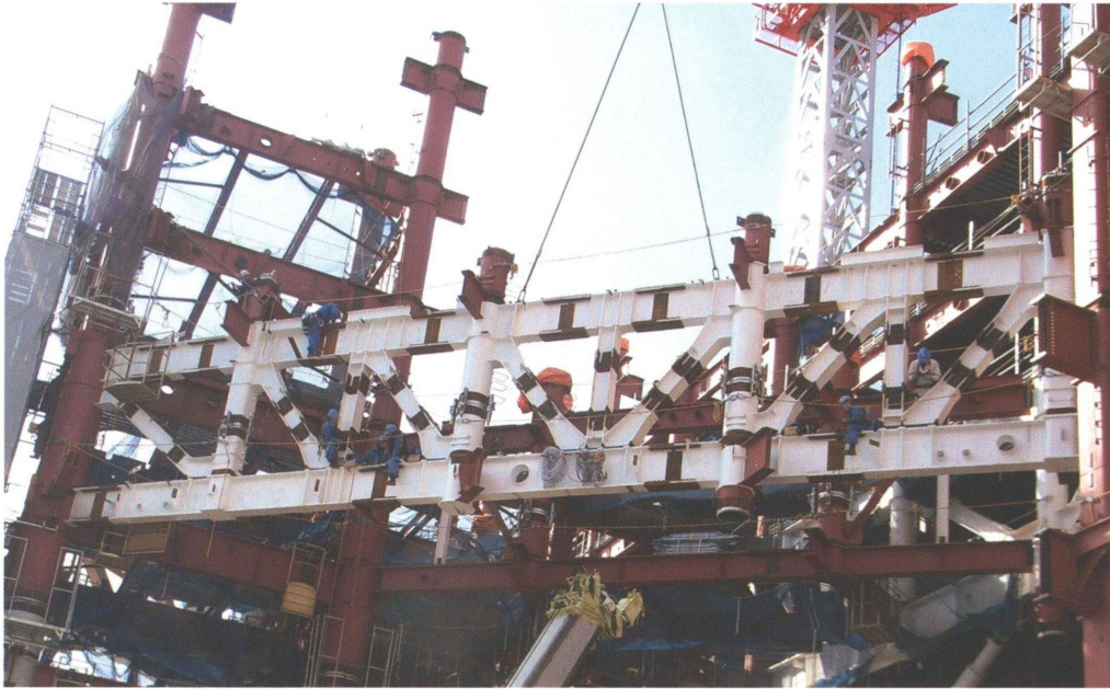
トラスの施工状況
