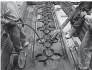
Photo. 5 コンクリート打設
