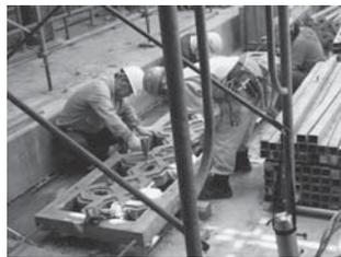
Photo. 6 型枠脱型
