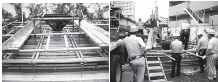
(d) 打設準備完了 (e) アジテータ車からの打設
