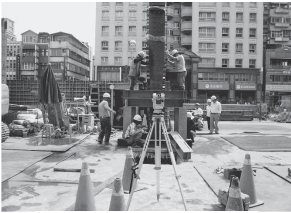
Photo. 2 構真柱建込み状況
