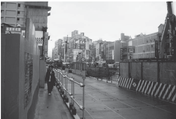
Photo. 3 前面信義路の状況
