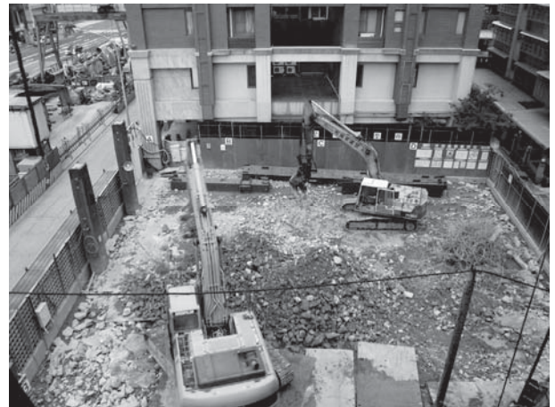
Photo. 4 鉄骨先行挿入完了状況
