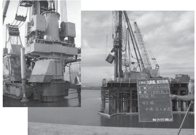
Photo. 2 オーガ併用バイプロハンマ
