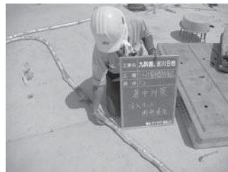
Photo. 5 ホースの日射養生
