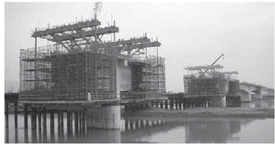
Photo. 3 張出し架設状況
