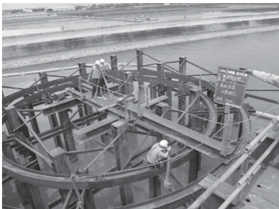
Photo. 1 導杭・導枠の設置完了
