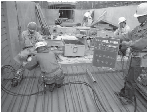
Photo. 7 仮設 PC 鋼棒の緊張
