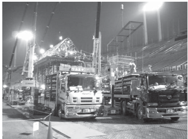
Photo. 19 本施工・パネル荷取り状況
