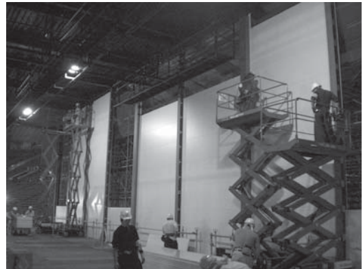
Photo. 14 壁パネル・施工状況・床上作業
