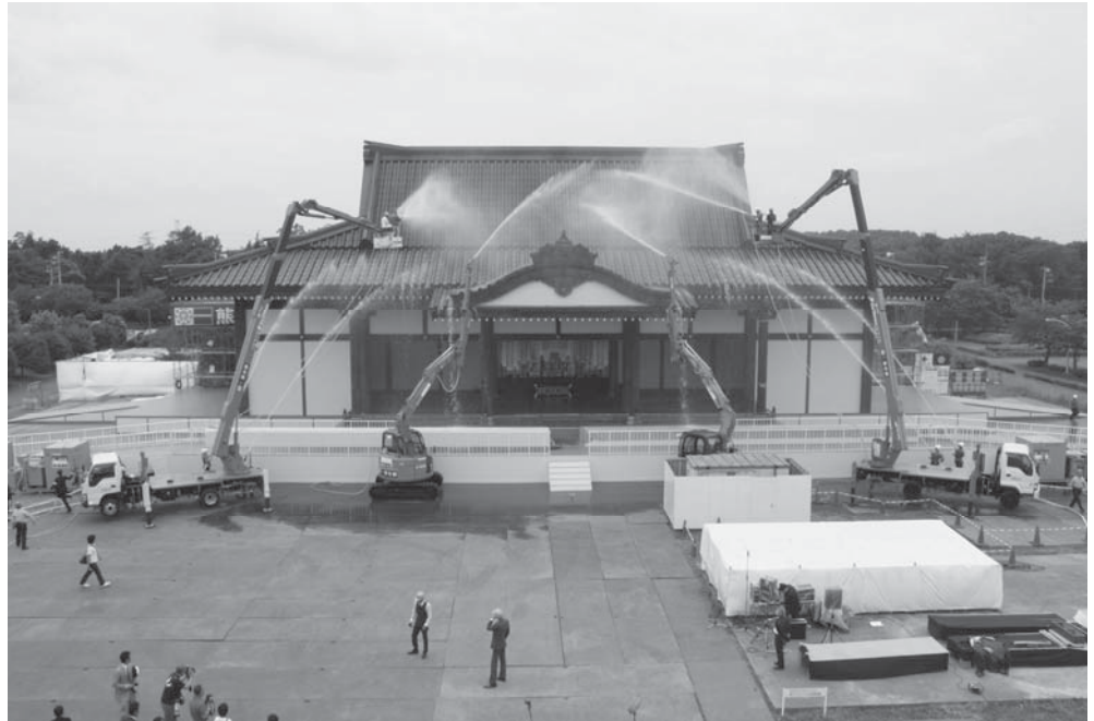
Photo. 18 放水テスト実施状況
