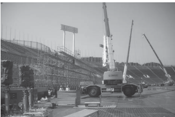
Photo. 20 足場組立状況 平成21年6月29日 9時頃
