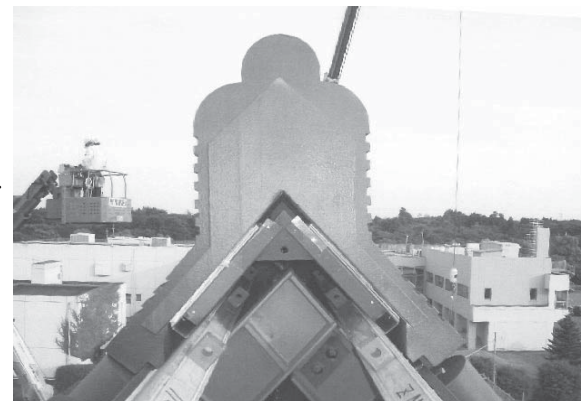
Photo. 9 同左部・施工状況
