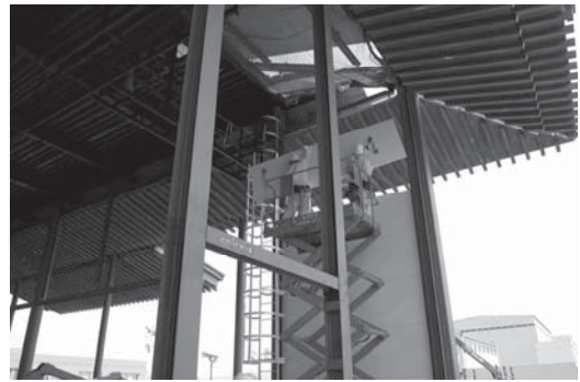
Photo. 13 壁パネル・施工状況
