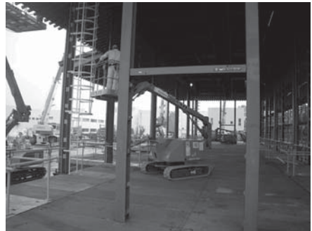
Photo. 15 床上作業状況・ 9m高所作業車
