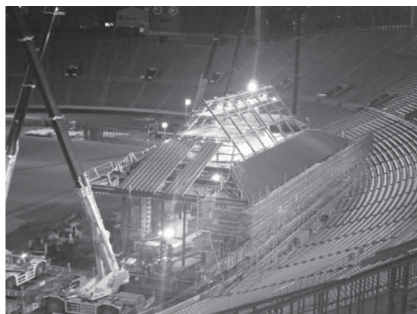
Photo. 25 屋根パネル施工状況 平成21年6月30日 22時頃
