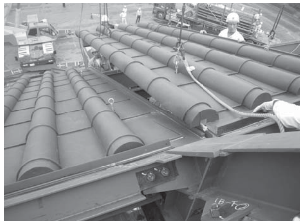
Photo. 11 ジョイント部・施工状況
