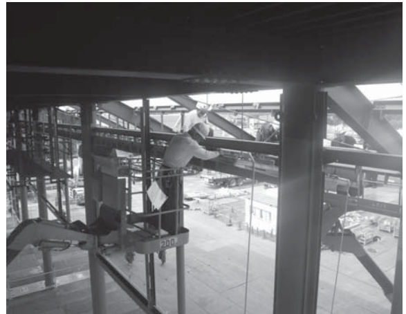
Photo. 7 同左部・施工状況
