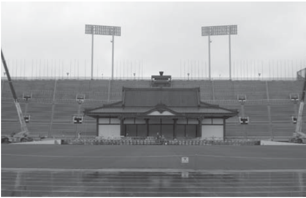
Photo. 28 外装完了 献花台組立状況 平成 21 年 7 月 2 日 8 時頃
