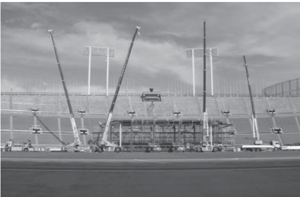
Photo. 32 鉄骨 解体状況 平成 21 年 7 月 7 日 15 時頃
