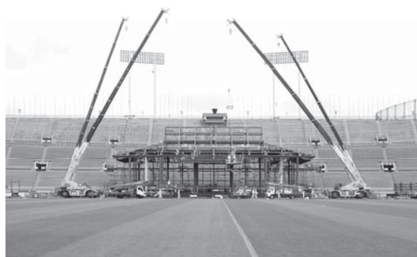
Photo. 23 軒天パネル施工状況 平成21年6月30日 10時頃
