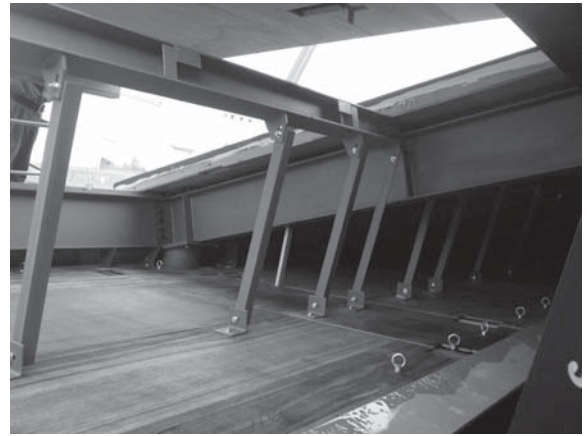
Photo. 6 屋根・軒先パネル取付け状況
