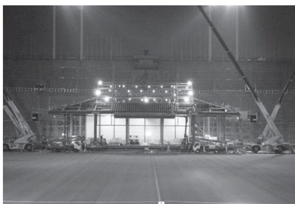
Photo. 26 屋根パネル施工状況 平成21年6月30日 23時頃
