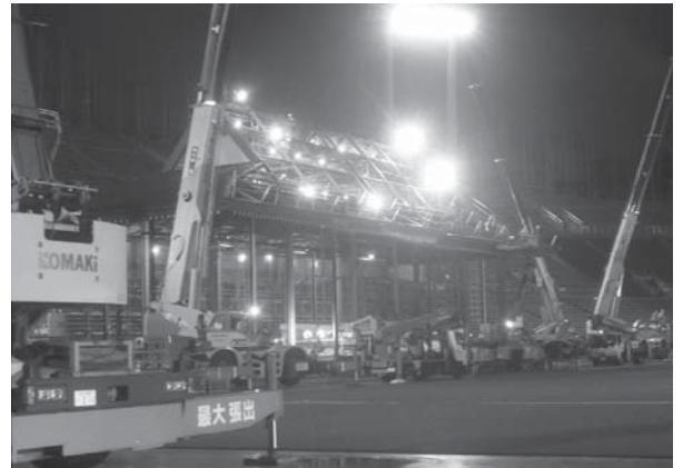
Photo. 31 屋根パネル 解体状況 平成 21 年 7 月 6 日 21 時頃
