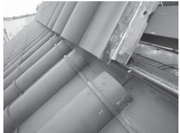
Photo. 8 同左部・施工状況
