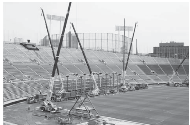
Photo. 21 鉄骨組立状況・柱建込 平成21年6月29日 15時頃
