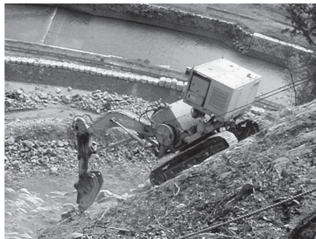
Photo. 7 オーバーハング部の掘削状況 (近景)
