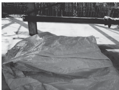
Photo. 5 下部コンクリート打設後の乾燥防止養生
