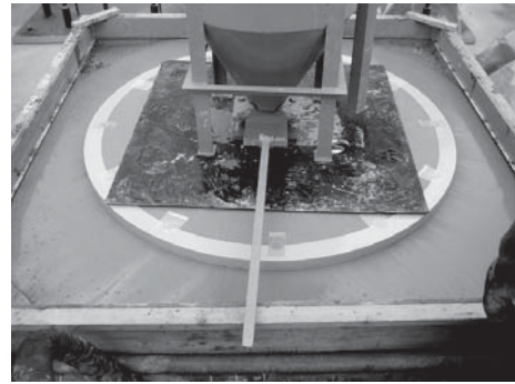
Photo. 9 グラウト材の充てん状況
