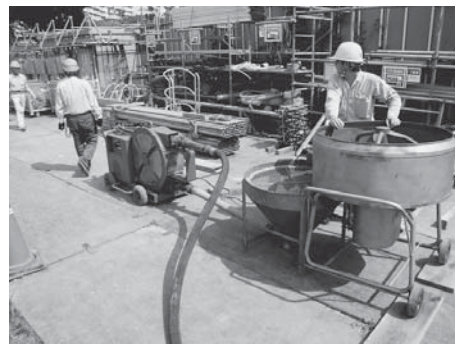
Photo 6 グラウト材の練混ぜ状況
