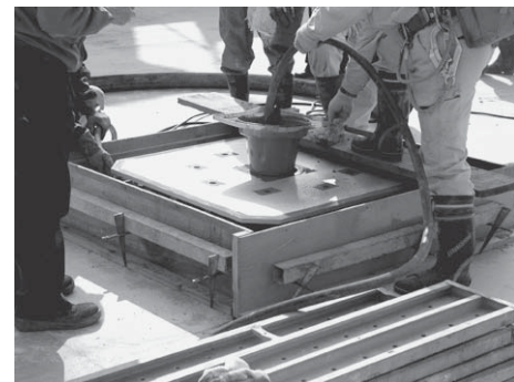
Photo. 3 下部コンクリート打設状況
