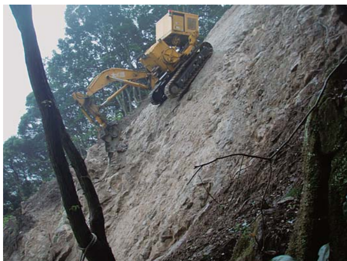
オーバーハング部の掘削状況(近景)
