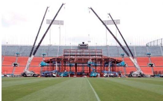
軒天パネルの施工 6月30日 18時
