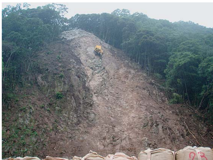
オーバーハング部の掘削状況(遠景)
