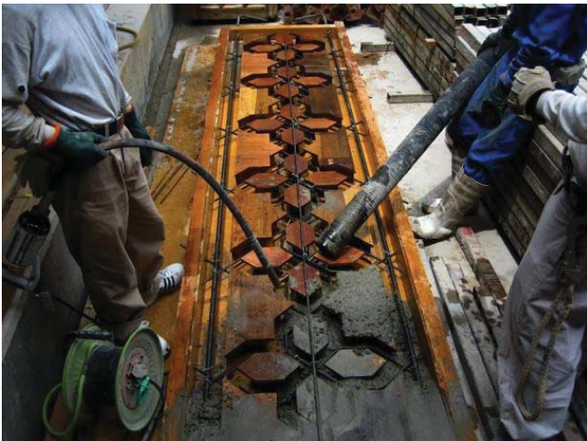
化粧格子・製作(コンクリート打設)状況
