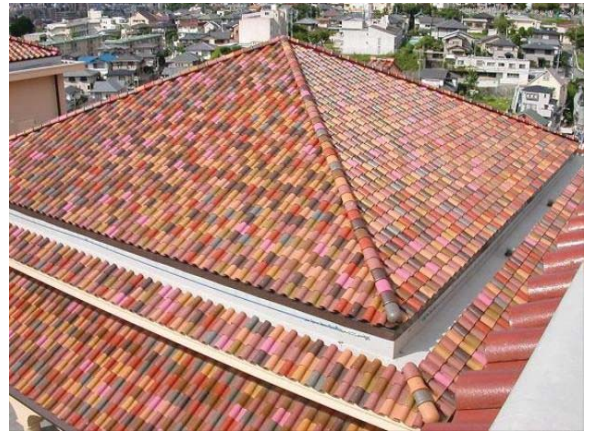
洋瓦葺き状況
