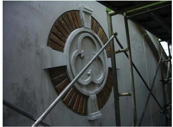
外壁打込みレリーフ・脱型状況
