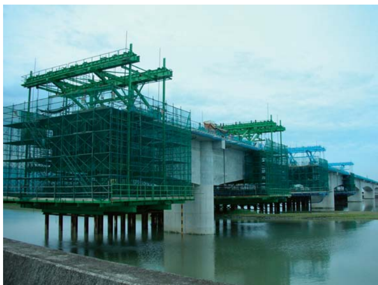
張出し架設状況
