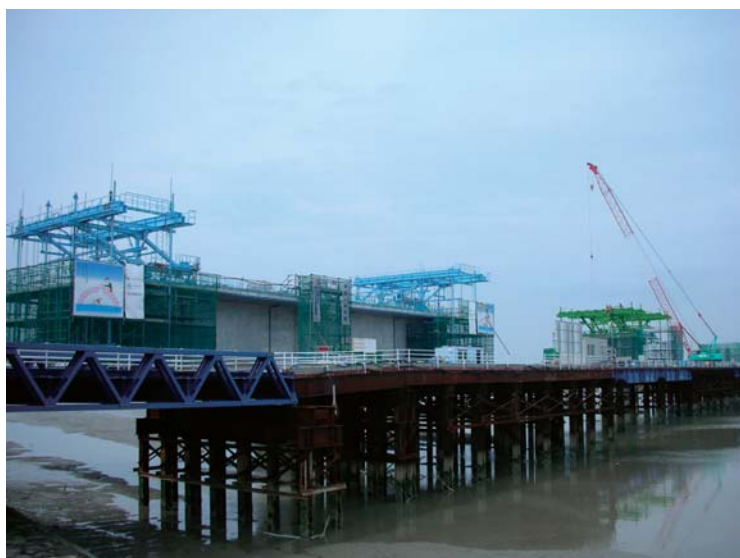
張出し架設状況
