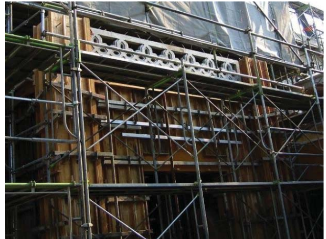
化粧格子・型枠取り付け状況
