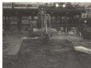
Photo. 4 仮設路盤 重機解体搬出状況
