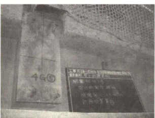
Photo. 64 梁筋プレート定着梁筋研出し左官下地状況
