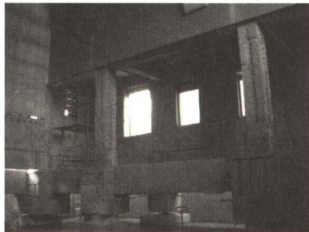
Photo. 47 仮設補強壁 解体搬出完了
