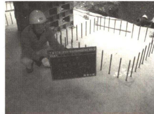
Photo. 16 免震下部基礎 樹脂アンカー施工完了
