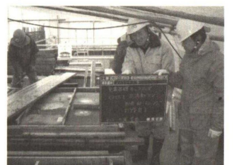
Photo. 8 CASE-1 高流動コン打設完了
