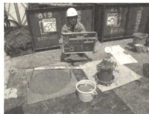
Photo. 56 吹抜独立柱補強 高流動コンクリート材料試験
