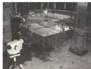
Photo. 20 免震装置下部 プレート据付検査状況 (弾性すべり支承)
