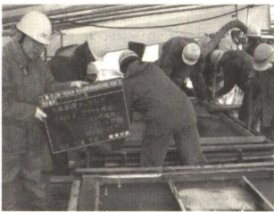
Photo. 9 CASE-2・3 下地基礎コン打設状況
