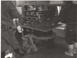
Photo. 29 免震装置据付状況
