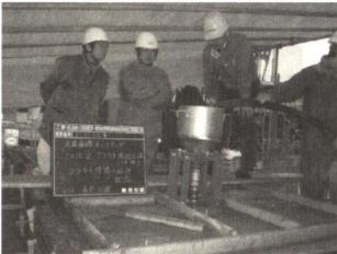
Photo. 11 CASE-2・3 グラウト材流込状況
