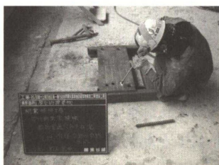
Photo. 65 梁筋プレート定着プレート実測孔開加工状況
