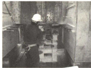
Photo 40 ジャッキアップ後 大楔撤去状況
