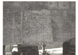
Photo. 33 免震基礎柱 フープ貫通部孔明け完了
