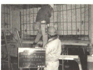
Photo. 51 免震上部基礎 鉄筋貫通部樹脂注入状況
