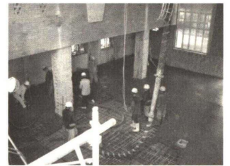
Photo. 53 免震上部基礎 コンクリート打設状況
