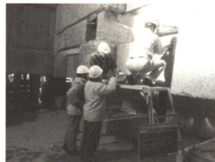
Photo. 32 既設躯体鉄筋探査状況
