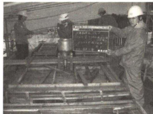
Photo. 12 CASE-2・3 グラウト材流込完了
