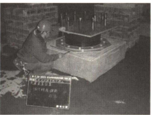
Photo. 30 免震装置 据付位置確認検査状況
