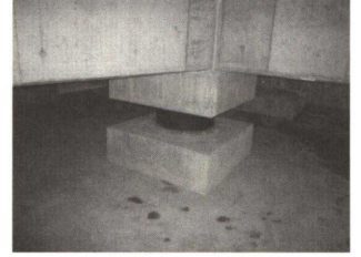
Photo. 55 免震上部基礎 型枠脱型出来形確認②
