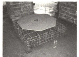
Photo. 21 免震装置下部 プレート据付状況 (高減衰積層ゴム支承)
