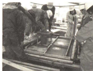
Photo. 7 CASE-1 高流動コン打設状況
