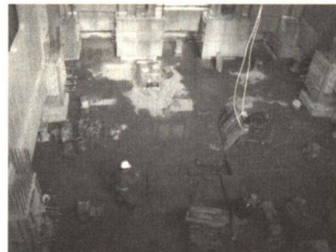
Photo 42 仮受け解体撤去状況
