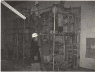
Photo. 62 新設耐震補強壁コンクリート打設状況
