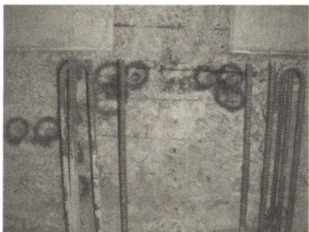
Photo. 48 免震上部基礎梁 梁筋貫通部孔開け状況
