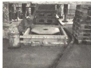
Photo. 22 免震装置下部 基礎コン打設前状況
