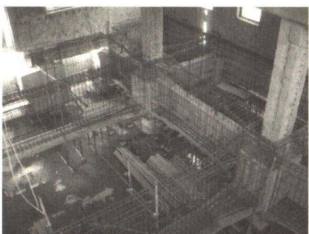
Photo. 50 免震上部基礎梁配筋完了
