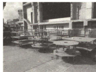
Photo. 18 免震装置下部 プレート搬入
