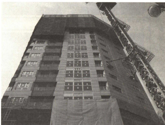
Photo. 6 基壇部および連層足場
