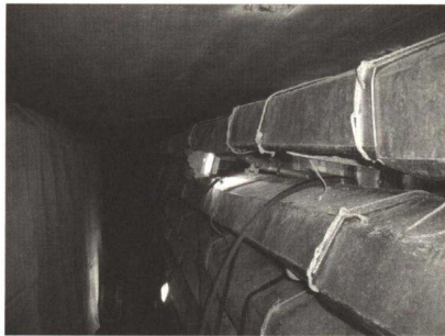
Photo. 3 防護工設置状況
