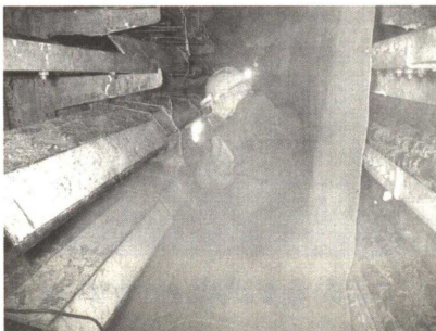
Photo. 5 WJ工法施工状況
