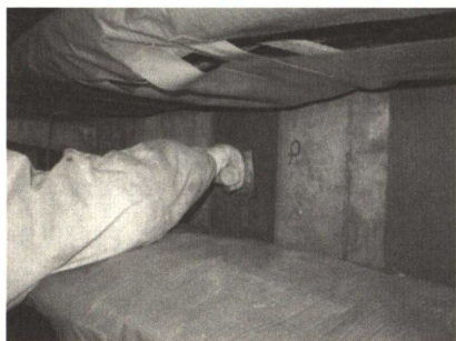
Photo 8 断面修復施工状況
