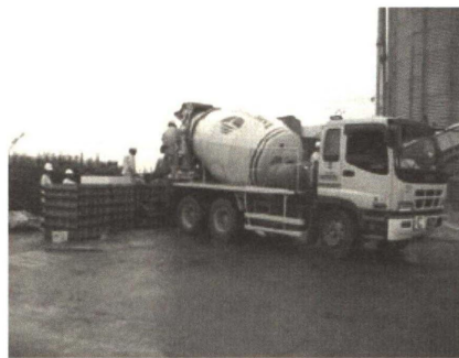
Photo. 3 ミキサ車で運搬
