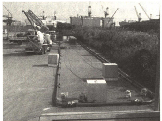
Photo. 8 ポンプ圧送試験の様子
