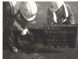
photo.5 無収縮モルタル
