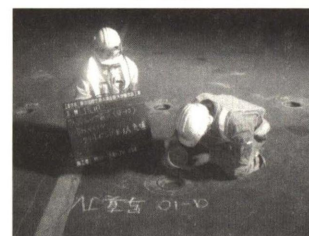
photo.7 エポキシ充填状況
