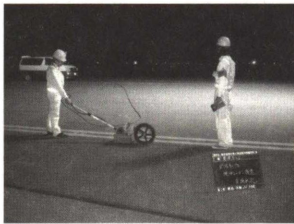
photo.2 地中レーダー探査
