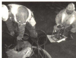
photo.4 インナー削孔機
