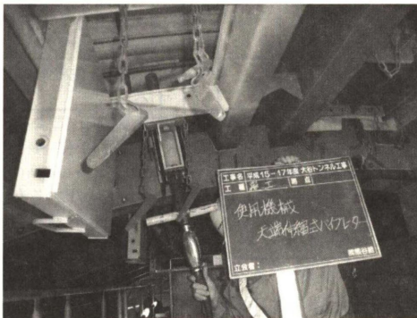
photo. 4 棒状ハイフレーター伸縮装置
