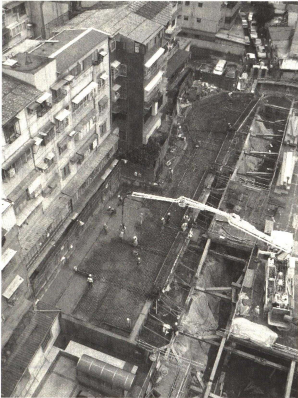
Photo. 5 先行床打設状況
