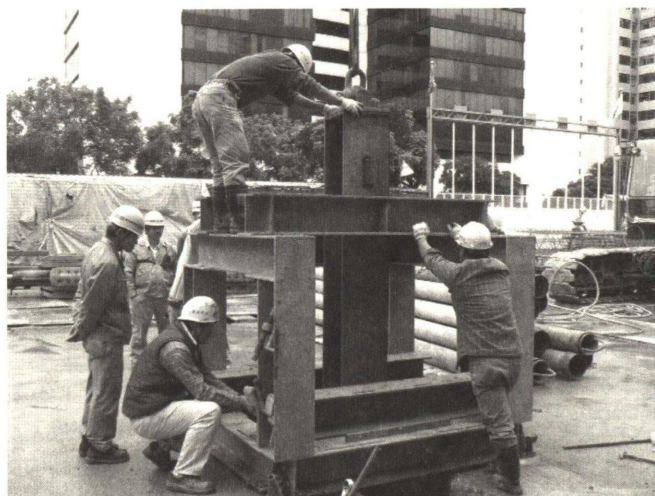
Photo. 4 構真柱建て込み状況
