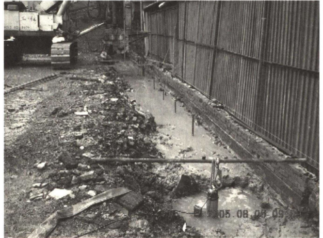
Photo2 マイクロパイル施工完了状況
