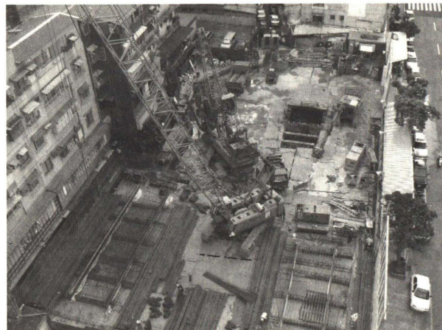
Photo. 3 連続地中壁施工状況
