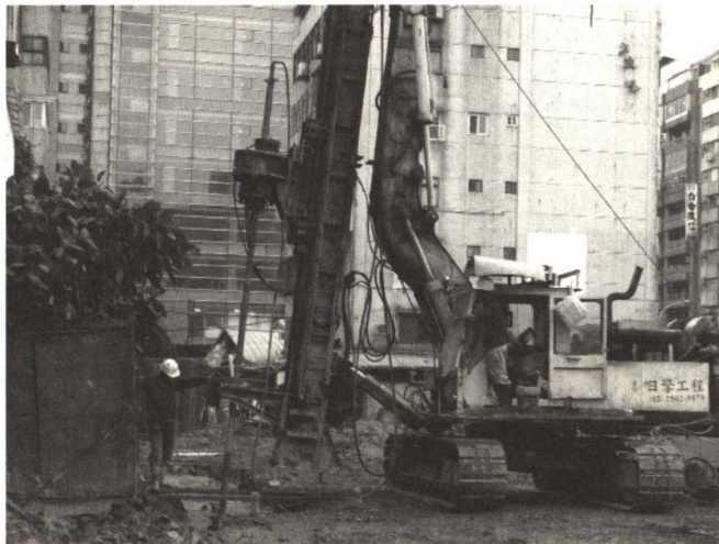
Photo1 マイクロパイル打設状況 (近景)
