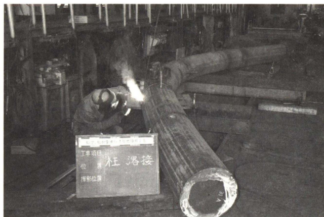
Photo. 3 鋼管の溶接作業
