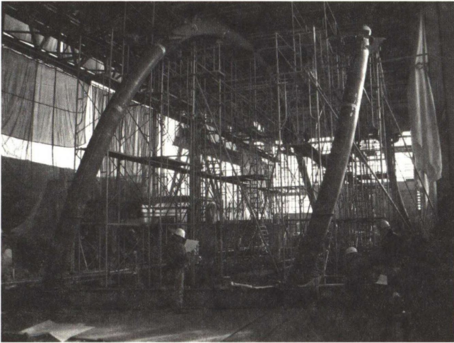
Photo. 5 スパイラルフレームの仮組み確認
