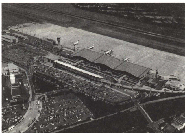
Photo. 15 仙台空港と仙台空港駅（航空写真）
