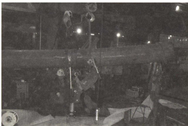
Photo. 4 膜受けジグの取り付け
