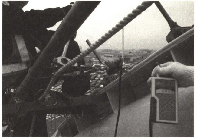
Photo. 11 張力導入作業
