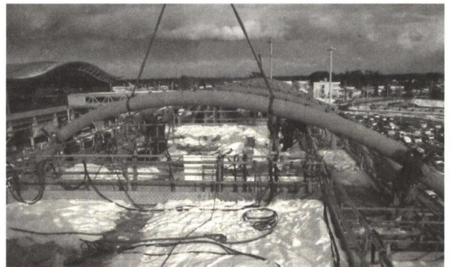
Photo. 8 スパイラルフレーム上部吊り込み
