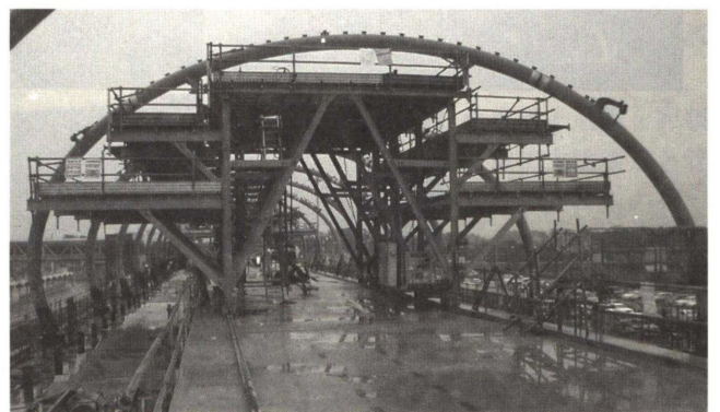
Photo. 9 スパイラルフレームの組み立て状況
