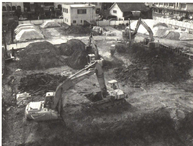
Fig. 9 グリッド掘削状況
